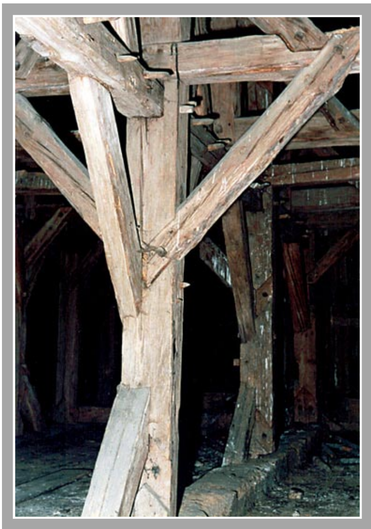
Il. 44. Dobrze zachowana drewniana więźba dachowa powyżej galerii strychowej. Fot autor
