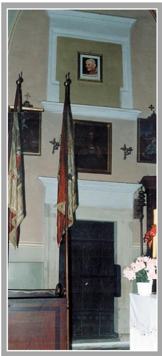
II. 21. Widok portalu prowadzącego z prezbiterium do zakrystii, powyżej zamurowane w XIX wieku okno empory. Fot. autor
