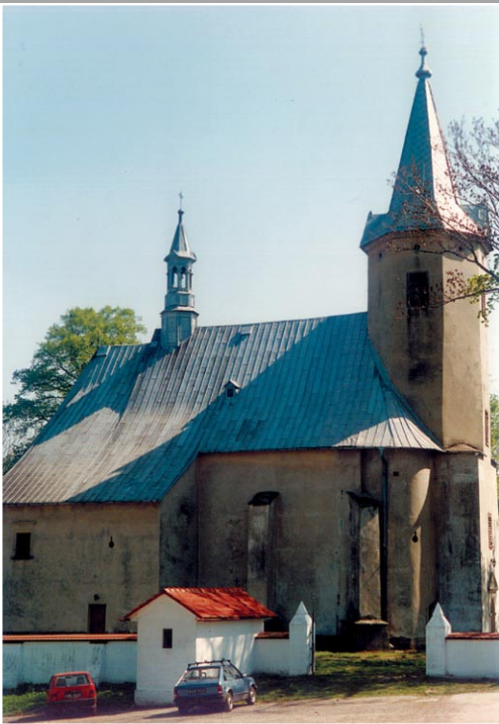
II. 12. Kościół, elewacja północna, widoczne trzy strzelnice, a w murze ogrodzenia: brama i dawna kapliczka. Fot. autor
