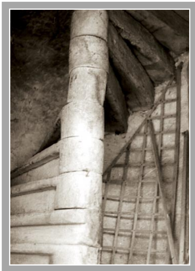
II. 41. Drewniane, dębowe schody w wieżyczce zachodniej prowadzące na obronną galerię strychową i wieżę kościoła. Fot. autor
