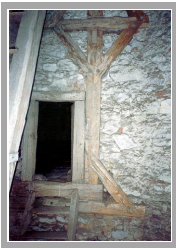
II. 42. Wejście do galerii obronnej ze strzelnicami na poddaszu, widoczny szachulcowy wątek muru wieży z 2. ćw. XVII wieku. Fot. autor
