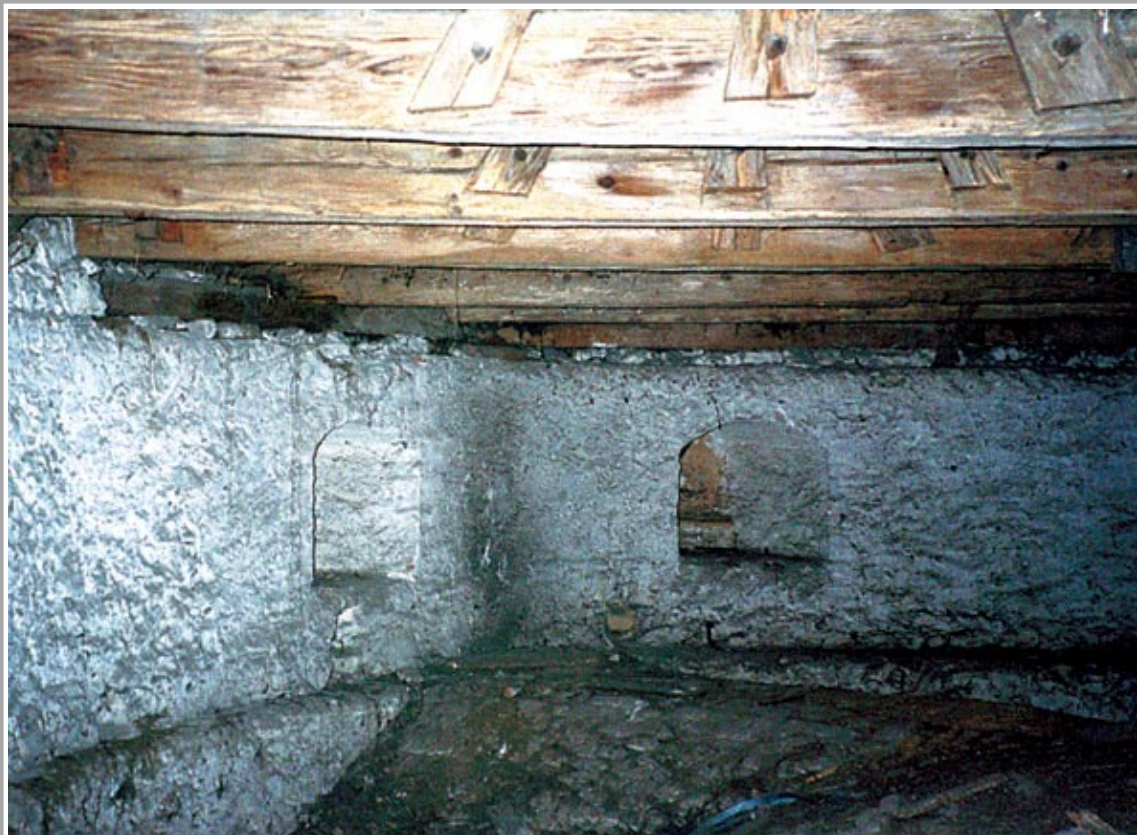
II. 43. Widok galerii obronnej na poddaszu świątyni z 1. poł. XVII wieku ze strzelnicami kluczowymi dla palnej broni ręcznej, przebitymi w murze, z odsadzką muru, służącą konstrukcyjnemu wsparciu drewnianego ganku ponad sklepieniem. Fot. autor
